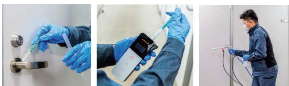
「光触媒コーティング」作業の様子
